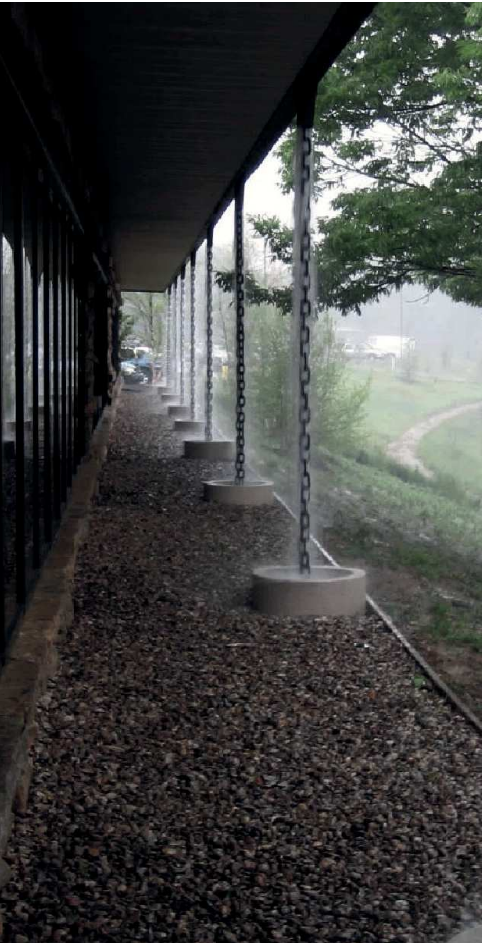
ESQUEMA GENERAL DE EVACUACIÓN DE AGUAS LLUVIAS NO ATRIO E EXEMPLO DE USO DE CORRENTES PARA SUA EVACUAÇÃO
